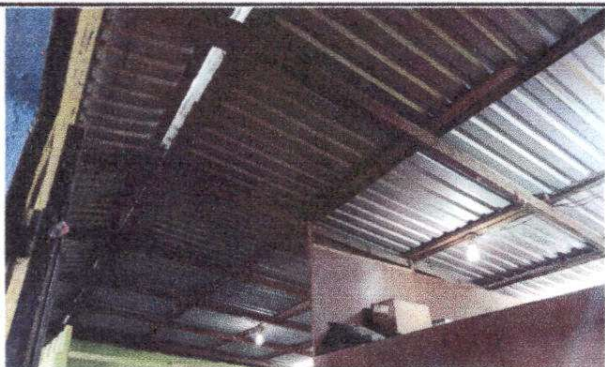
Foto1: Cubierta de Lamina (Aula 2)
