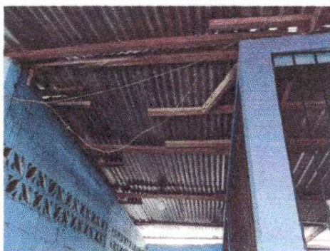
Foto 3: Estructura de Techo
