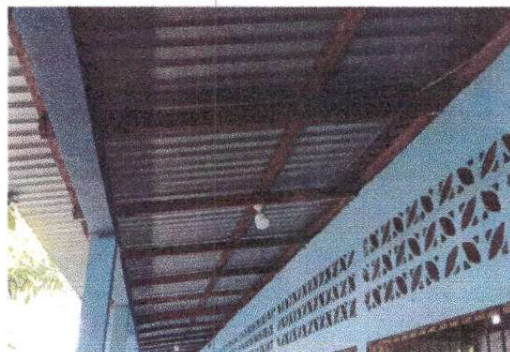
Foto 4: Estructura de Techo
