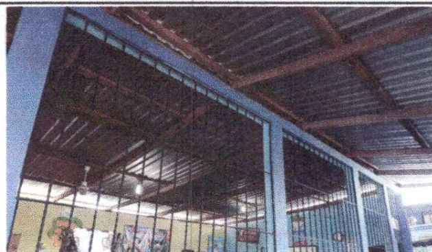
Foto 2: Cubierta de Lamina (Aula 1)
