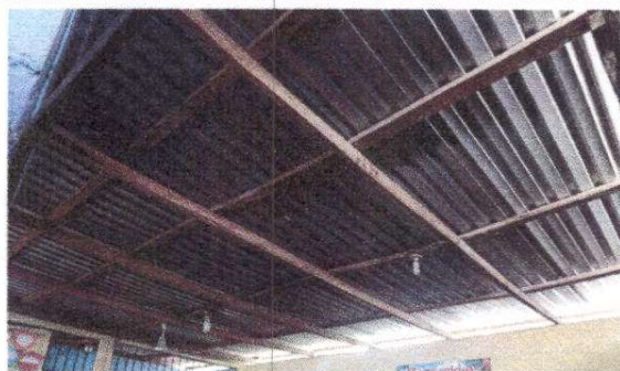
Foto 6: Reparacion de Sistema Electrico Aula 1
