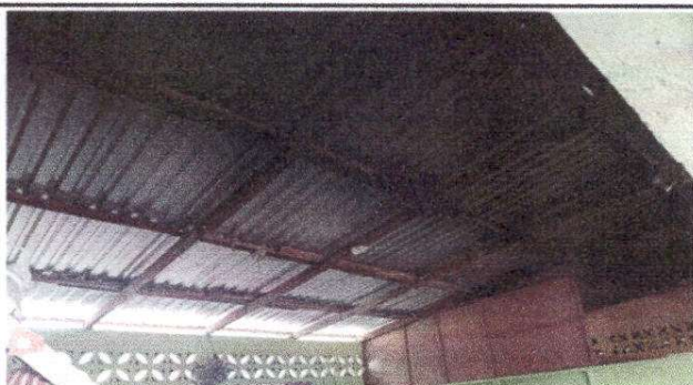
Foto 5: Reparacion de Sistema Electrico Aula 2
